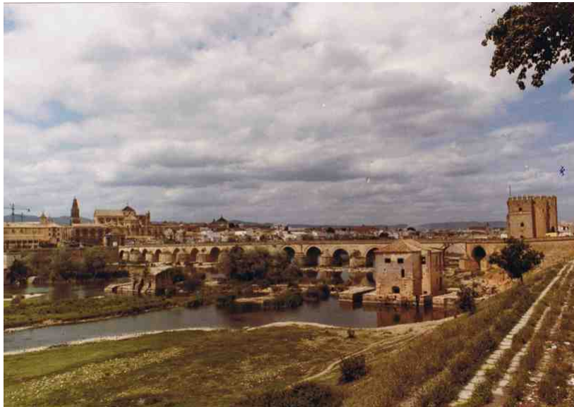
Ponte romano sul Guadalquivir
